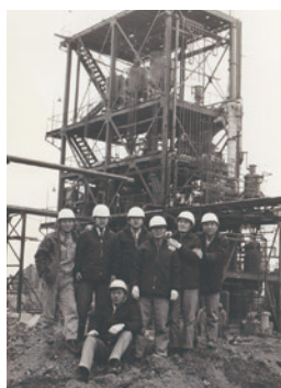
建設現場での記念写真
