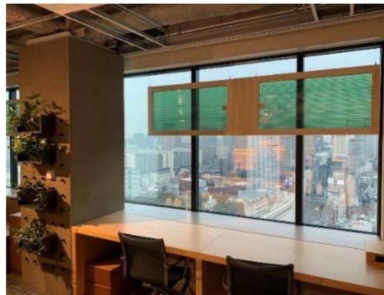
窓枠パネルへのOPV搭載
