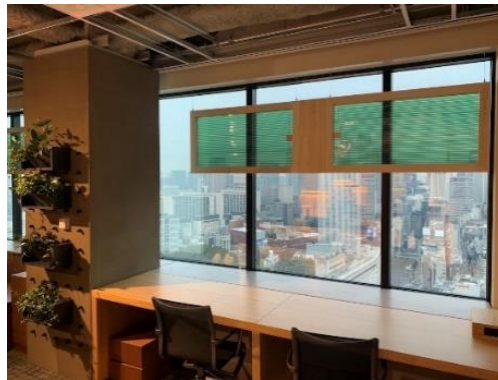
窓枠パネルへのOPV搭載 ビルメンテナンス会社へ設置
