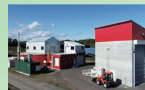
北興バイオガスプラント
